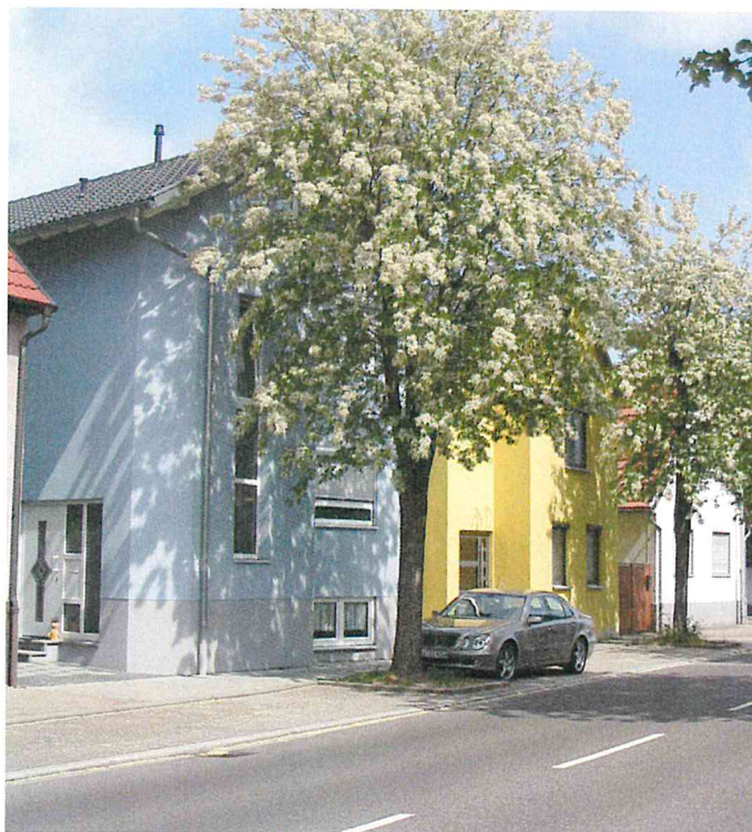
Abb. 4 Oben: neue Bebauung entlang der Hauptstraße
